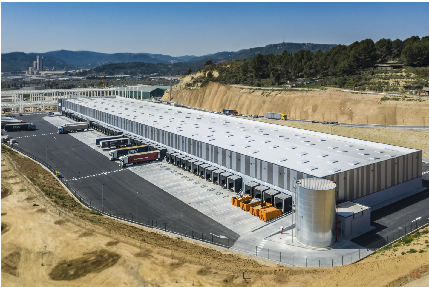
La instalación logística multinivel desarrollada por Goodman para DSV en Molins de Rei, Barcelona.
