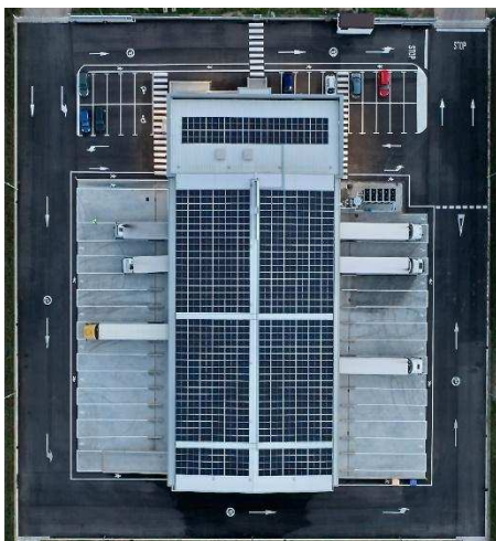
Plataforma logística refrigerada llaves en mano en Girona
