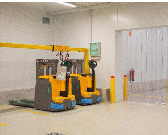
Locales de carga de baterías
